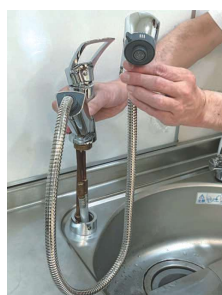
②シャワータイプ蛇口 取り外し
