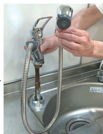
②シャワータイプ蛇口 取り外し
