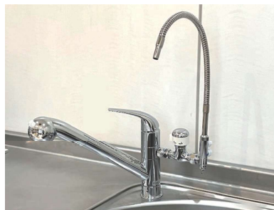
③分岐付き蛇口に交換し、分岐止水栓、 リターンバルブを取り付ける。
