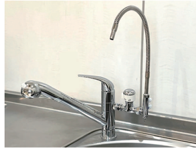
③分岐付き蛇口に交換し、分岐止水栓、 リターンバルブを取り付ける。
