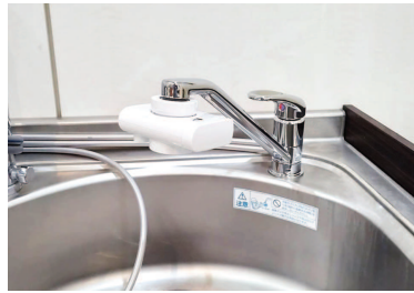
③標準取付可能な蛇口に交換し、 標準取付を行う
