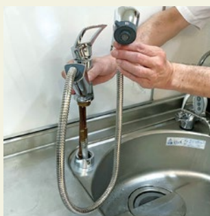
②シャワータイプ蛇口取り外し
