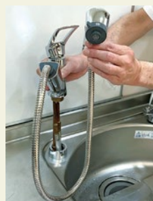
②シャワータイプ蛇口 取り外し
