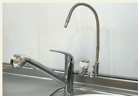
③分岐付き蛇口に交換し、分岐止水栓、リターンバルブを取り付ける。
