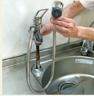
②シャワータイプ蛇口取り外し
