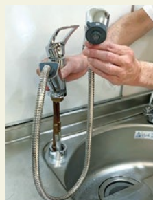
②シャワータイプ蛇口 取り外し
