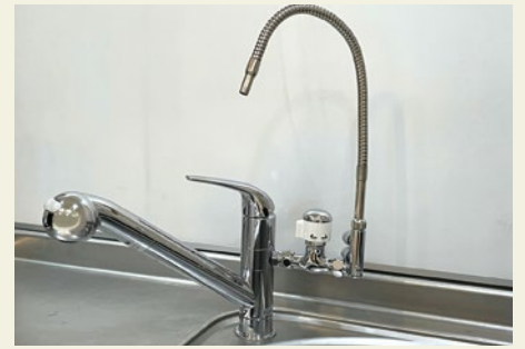
③分岐付き蛇口に交換し、分岐止水栓、リターンバルブを取り付ける。
